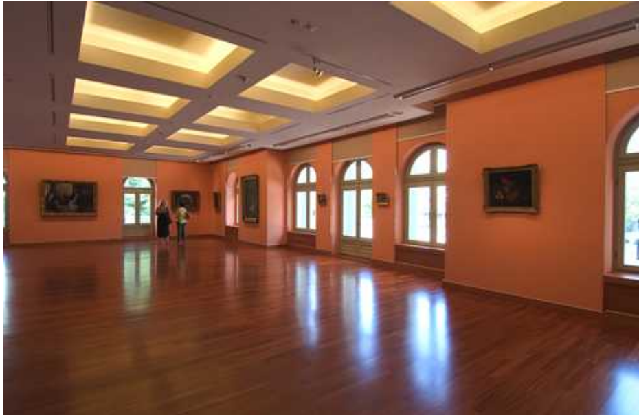
Rejtett fénycsöves általános világítás
