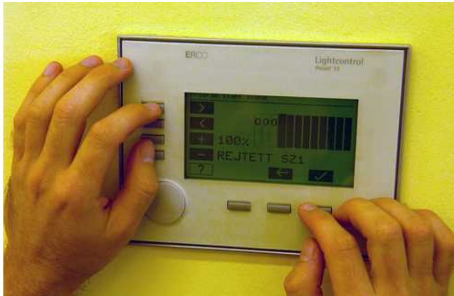
Programozott világítási rendszer kezelőszerve
